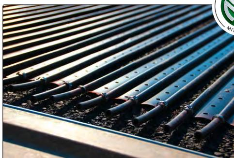
Die Heizmatten der Rasenheizung bestehen aus EPDM-Gummiröhrchen, die durch Stege miteinander verbunden sind
